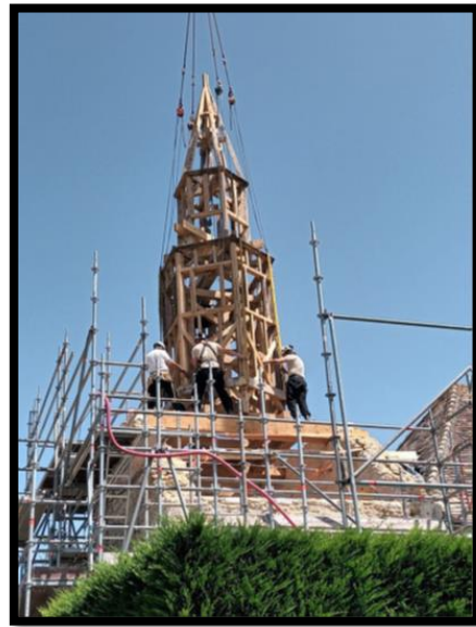
Les travaux de l'Eglise
